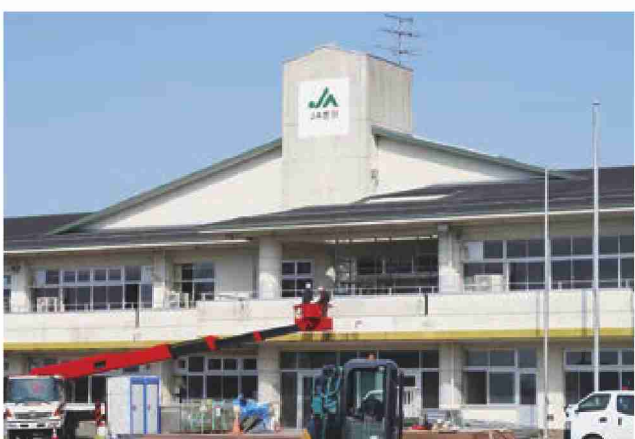
工事中の新本店の様子
